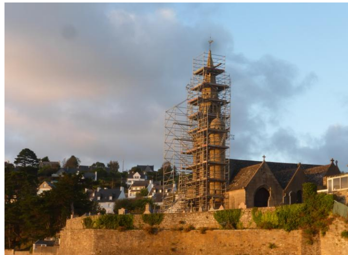
Réfection du clocher et d'un mur de l'église
