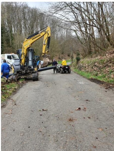
Ecoulement des eaux au cun
