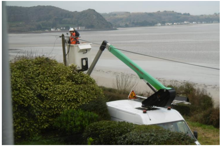
Effacement du réseau filaire route de Bellevue.
