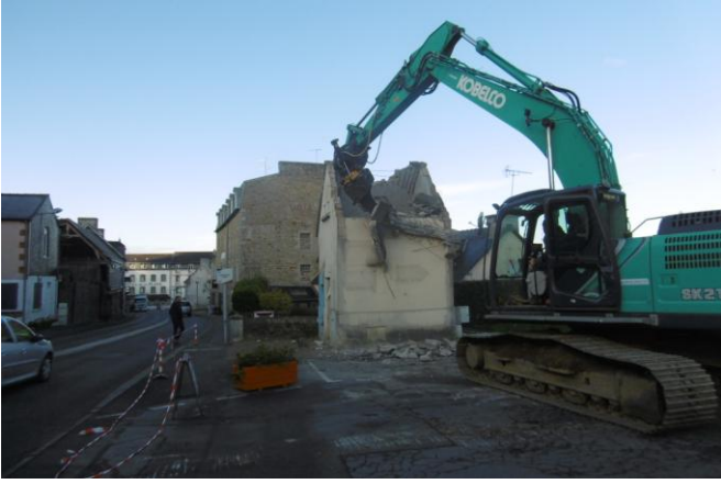
Destruction du vieux transfo inutile.
