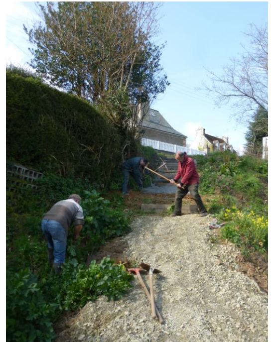
Nettoyage route des moulins et création d'un escalier.
