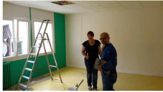
Réfection de la cantine
