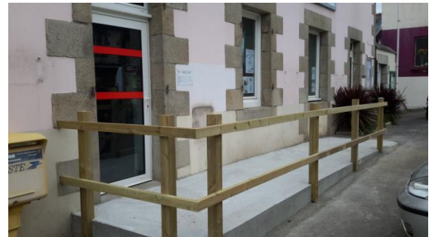
Rampe d'accès pour personnes handicapées à la poste
