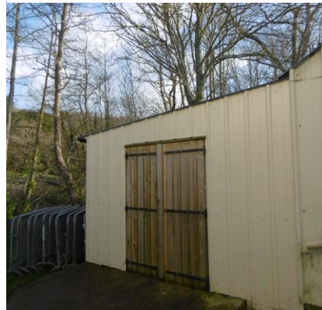
Réalisation d'un local de rangement
